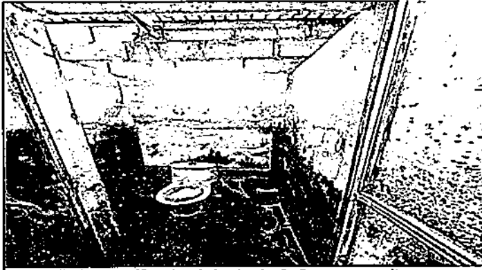
Foto 7: Baño para niños de edad entre 4 a 6 años que necesita mejoramiento en las paredes.
